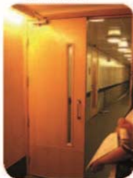
● 一期內的殘疾人士洗手間和升降機設於防火門後
