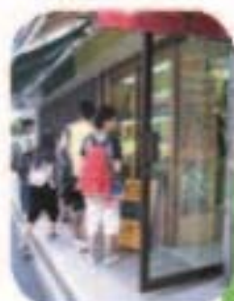
● 商店門前有台階，令輪椅使用者不能進入
