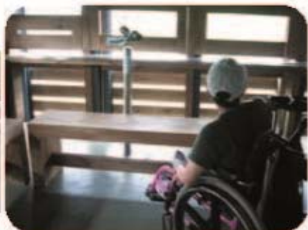
● 觀鳥屋內的望遠鏡設備被長椅阻礙
