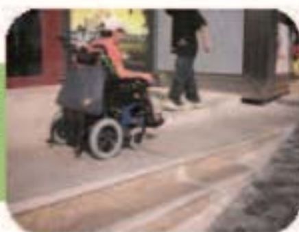
● 凌霄閣入口設有斜坡，但欠缺扶手
