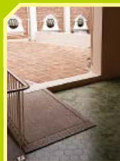
大樓設斜台通往平台
