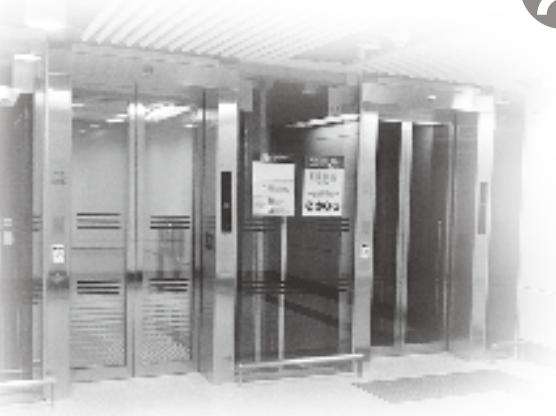
長沙灣港鐵站連接路面與大堂升降機
